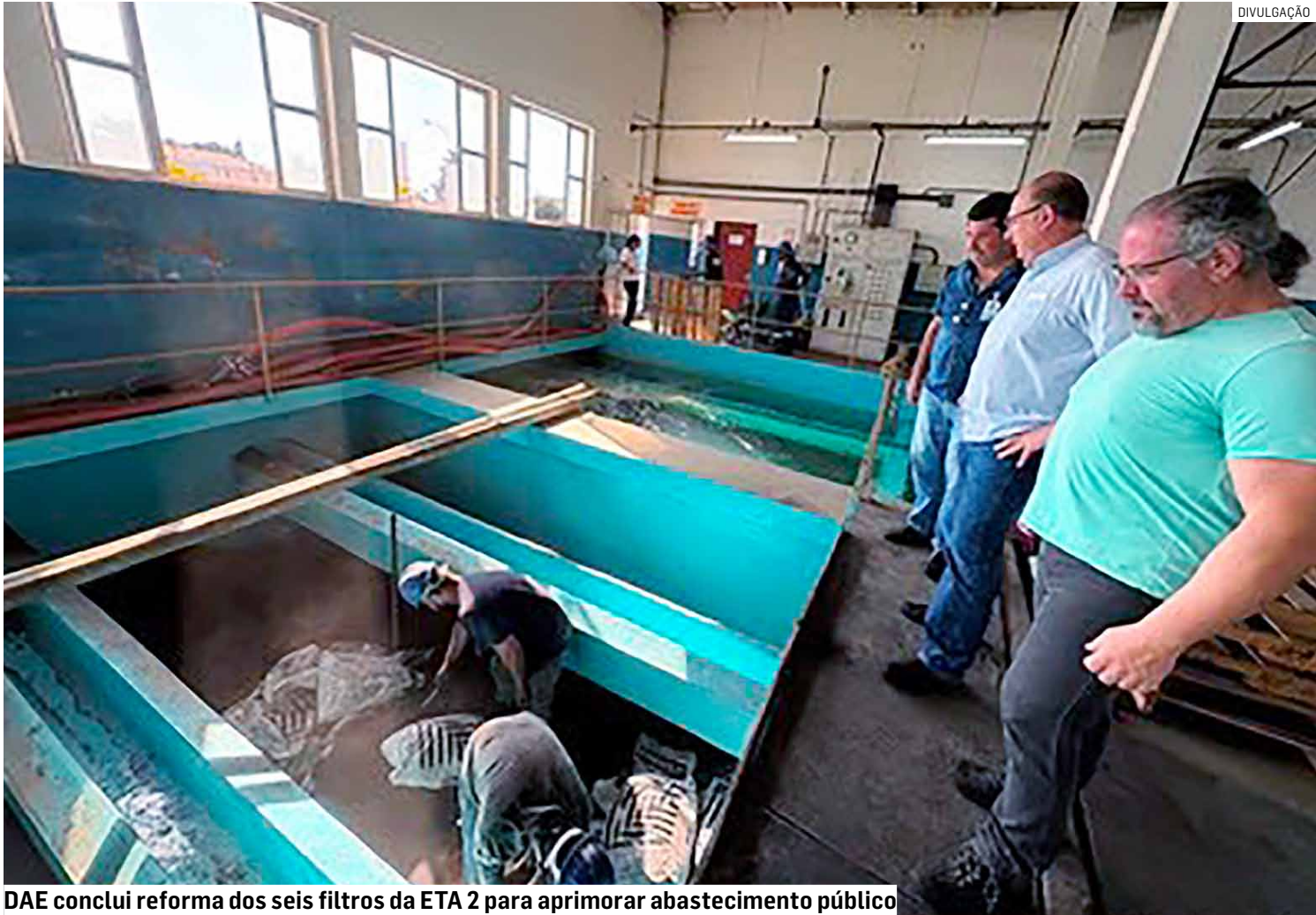
DAE conclui reforma dos seis filtros da ETA 2 para aprimorar abastecimento público
