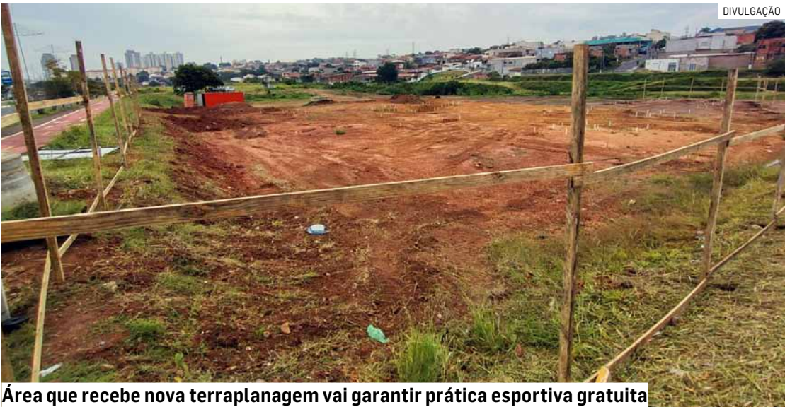
Área que recebe nova terraplanagem vai garantir prática esportiva gratuita
