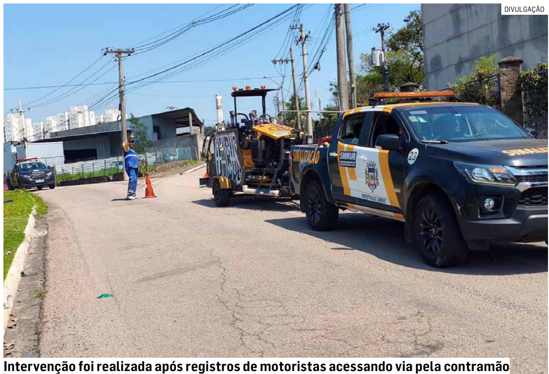
Intervenção foi realizada após registros de motoristas acessando via pela contramão
