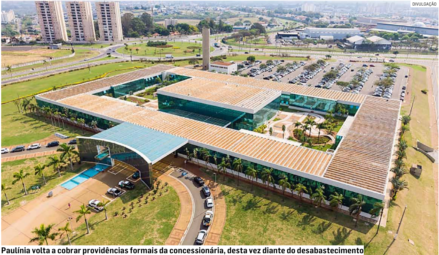
Paulínia volta a cobrar providências formais da concessionária, desta vez diante do desabastecimento
