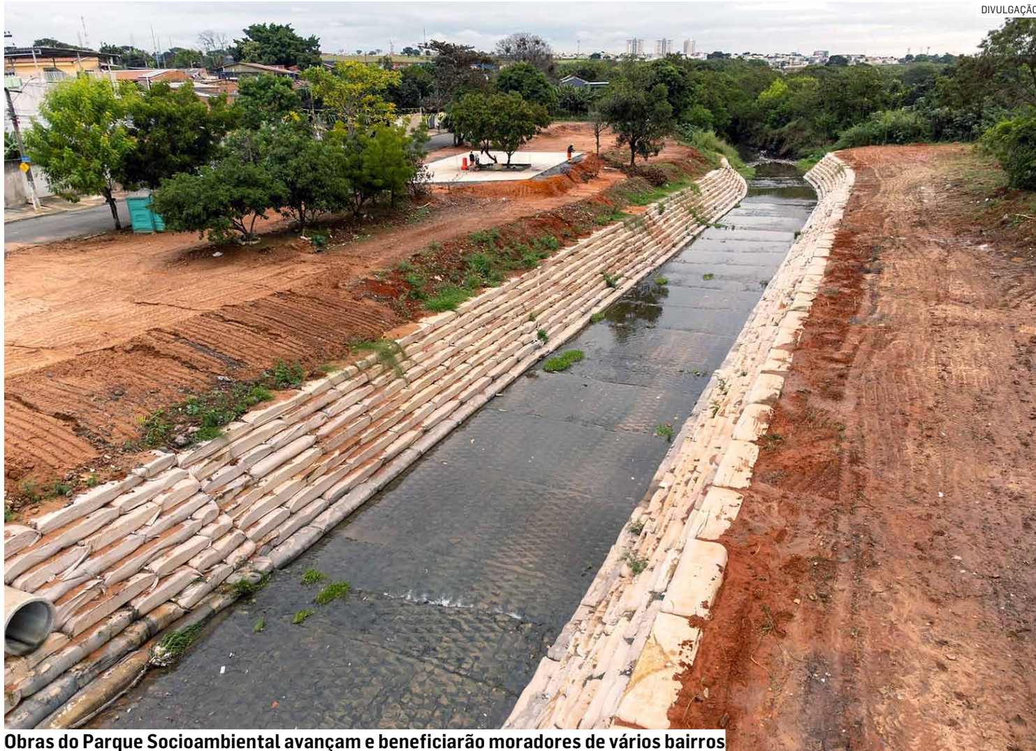
Obras do Parque Socioambiental avançam e beneficiarão moradores de vários bairros
