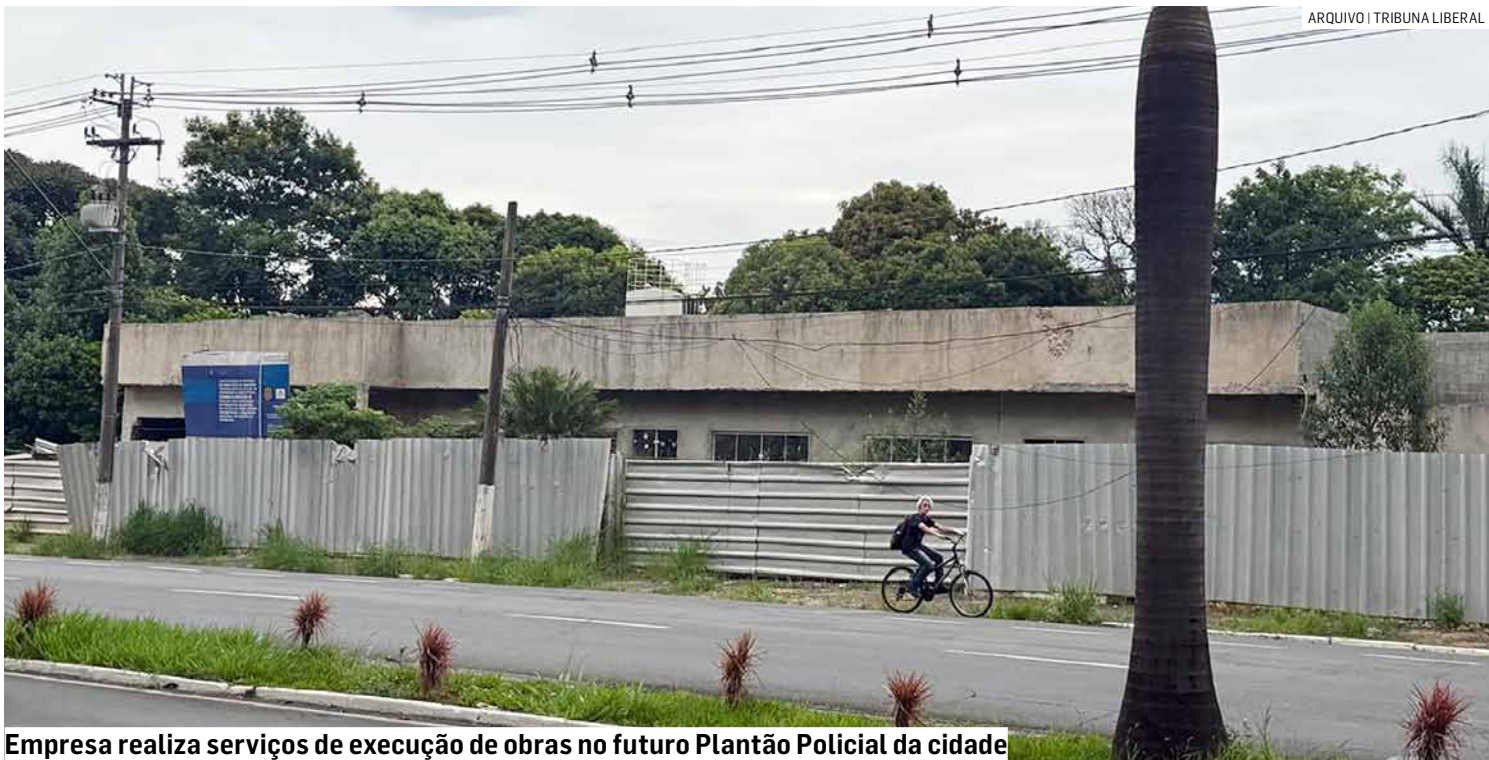
Empresa realiza serviços de execução de obras no futuro Plantão Policial da cidade
