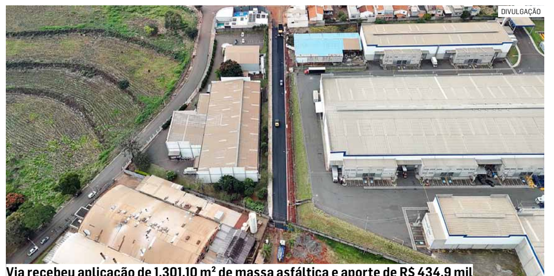
Via recebeu aplicação de 1.301,10 m 2 de massa asfáltica e aporte de R$ 434,9 mil
