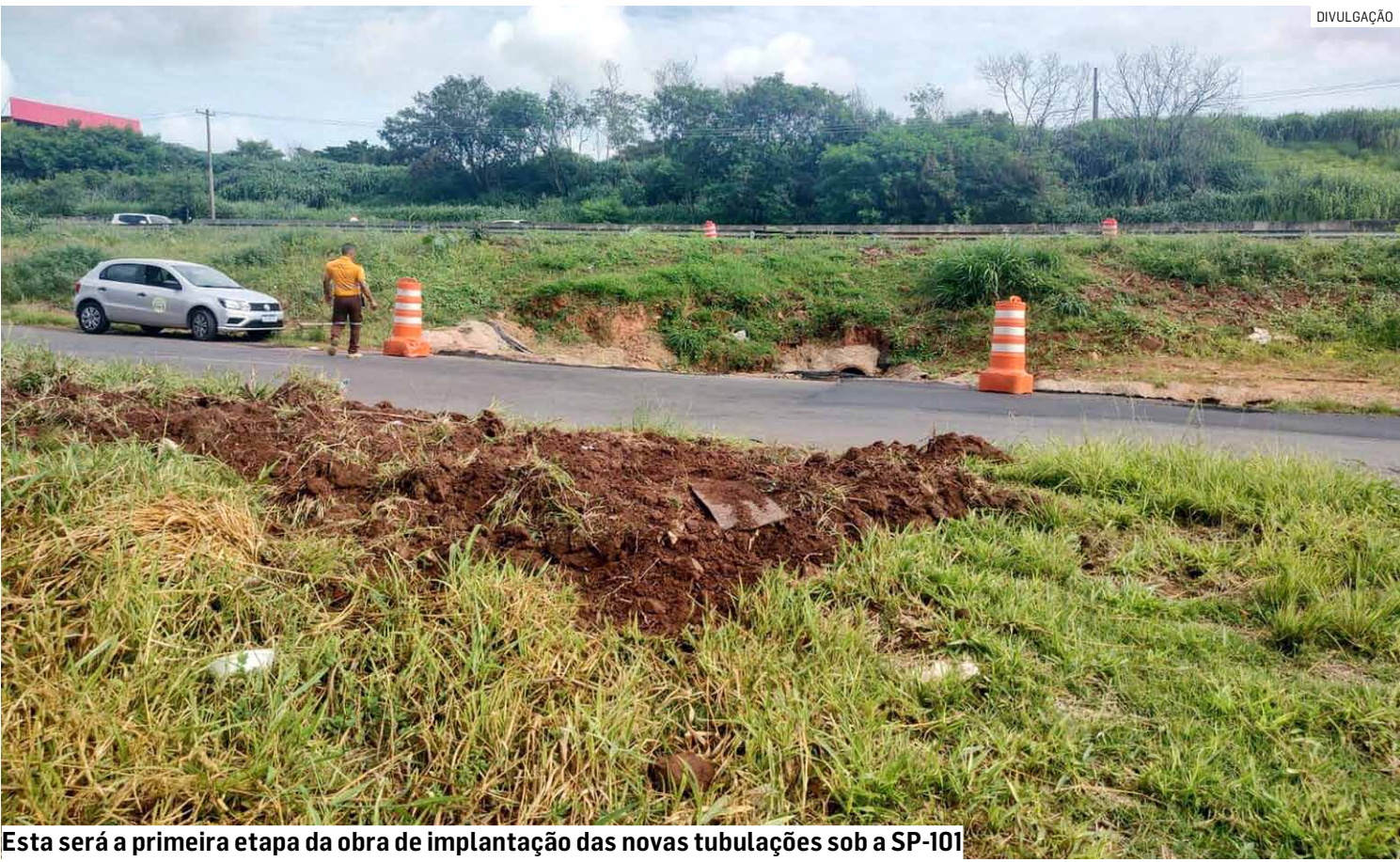
Esta será a primeira etapa da obra de implantação das novas tubulações sob a SP-101
