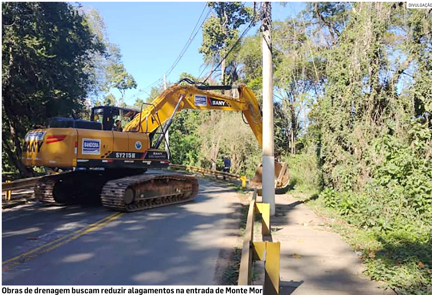
Obras de drenagem buscam reduzir alagamentos na entrada de Monte Mor
