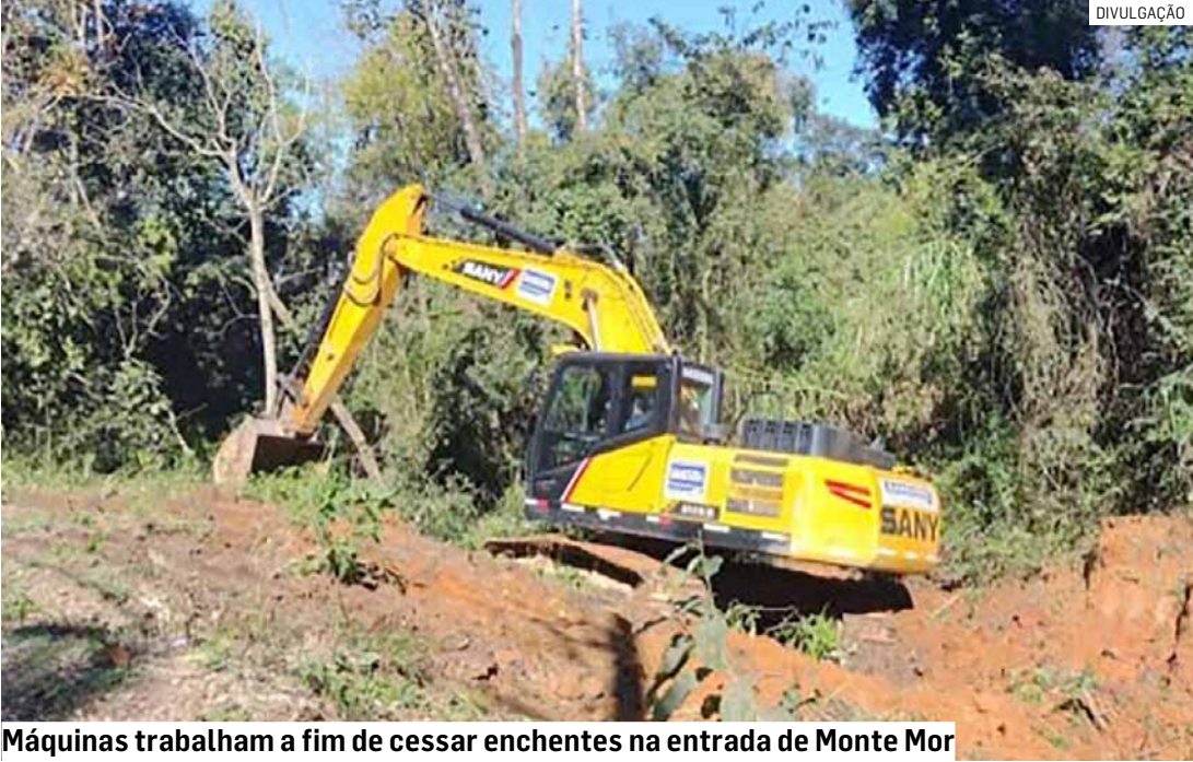
Máquinas trabalham a fim de cessar enchentes na entrada de Monte Mor
