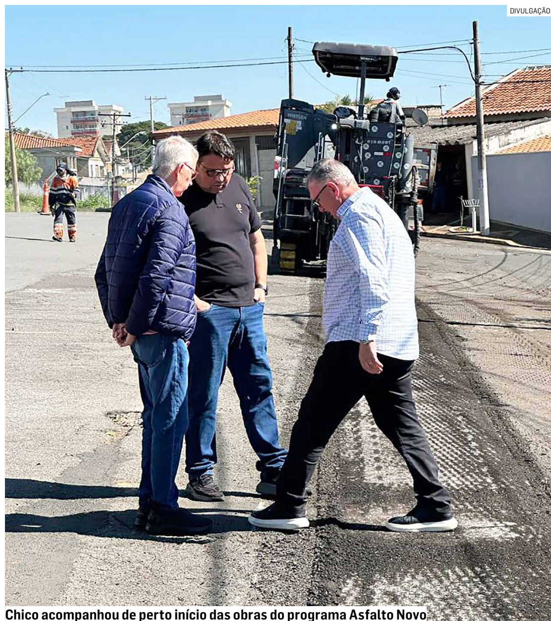
Chico acompanhou de perto início das obras do programa Asfalto Novo
