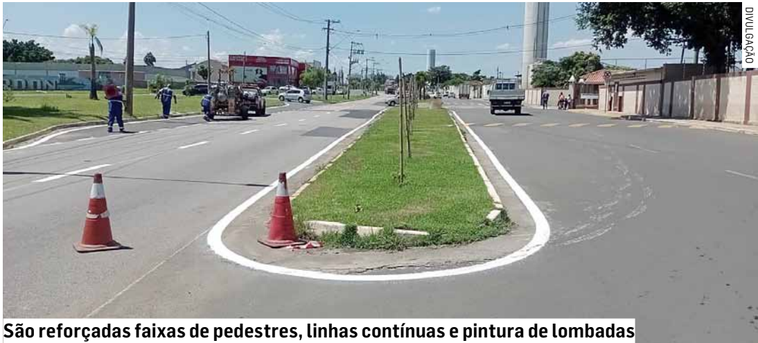
São reforçadas faixas de pedestres, linhas contínuas e pintura de lombadas
