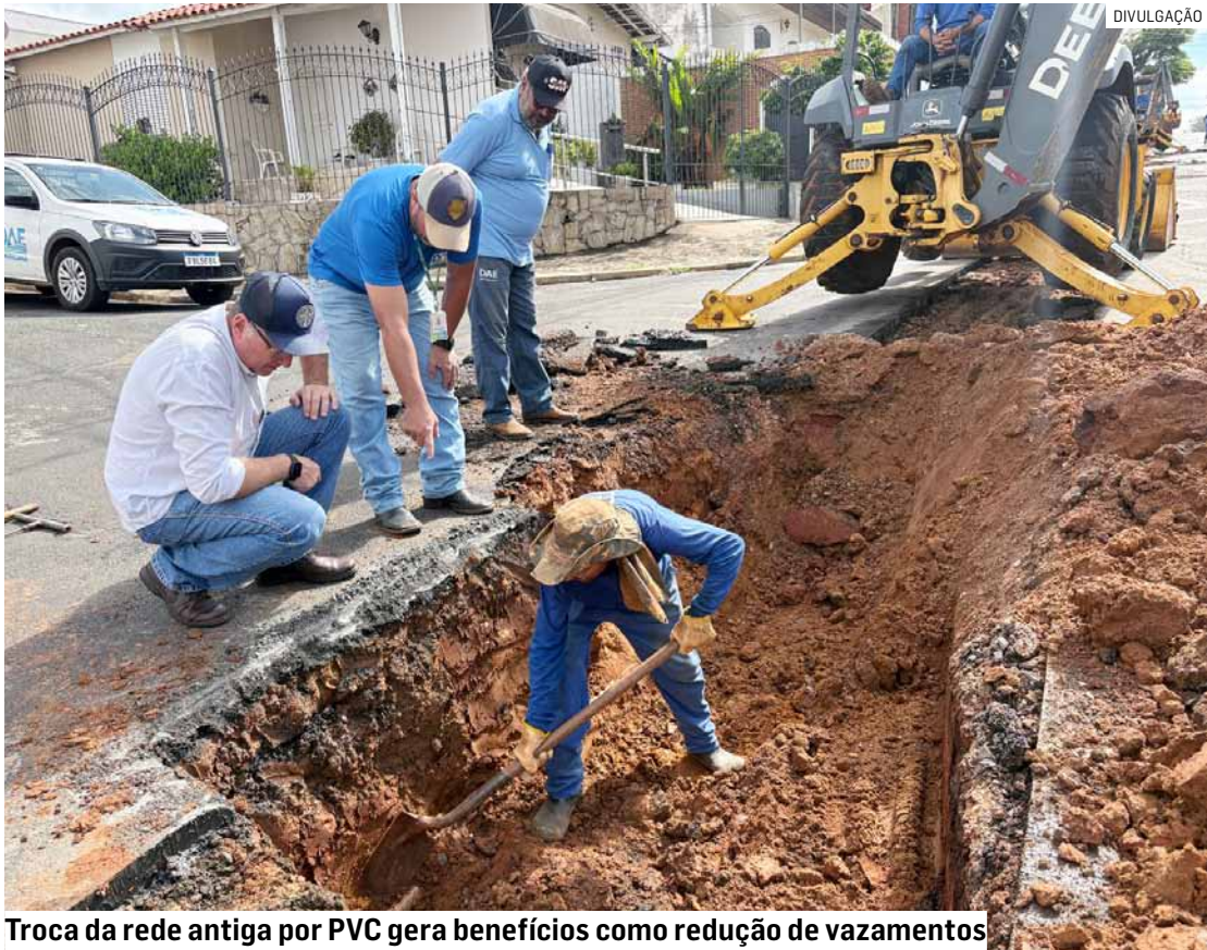
Troca da rede antiga por PVC gera benefícios como redução de vazamentos
