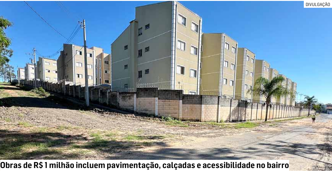
Obras de R$ 1 milhão incluem pavimentação, calçadas e acessibilidade no bairro
