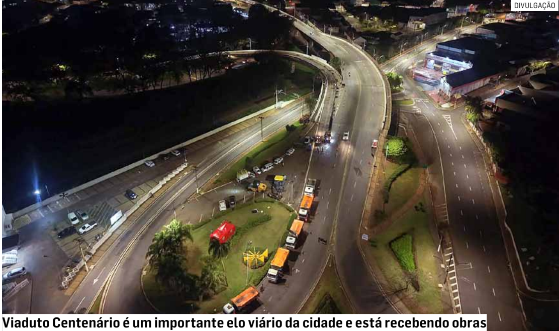
Viaduto Centenário é um importante elo viário da cidade e está recebendo obras
