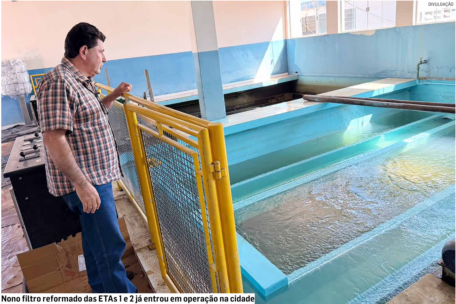
Nono filtro reformado das ETAs 1 e 2 já entrou em operação na cidade
