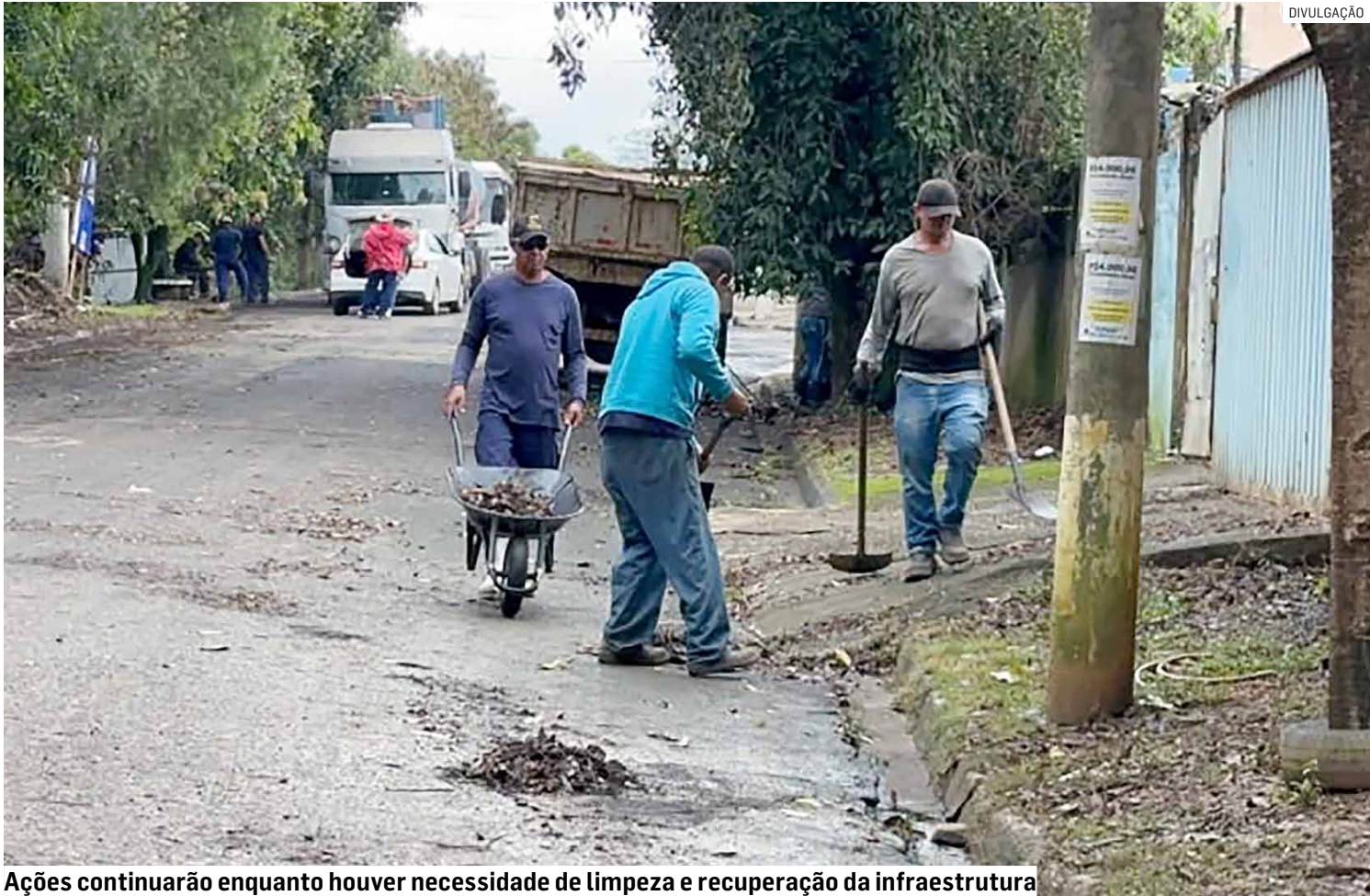
Ações continuarão enquanto houver necessidade de limpeza e recuperação da infraestrutura
