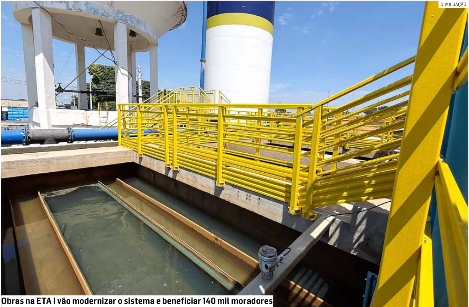
Obras na ETA I vão modernizar o sistema e beneficiar 140 mil moradores
