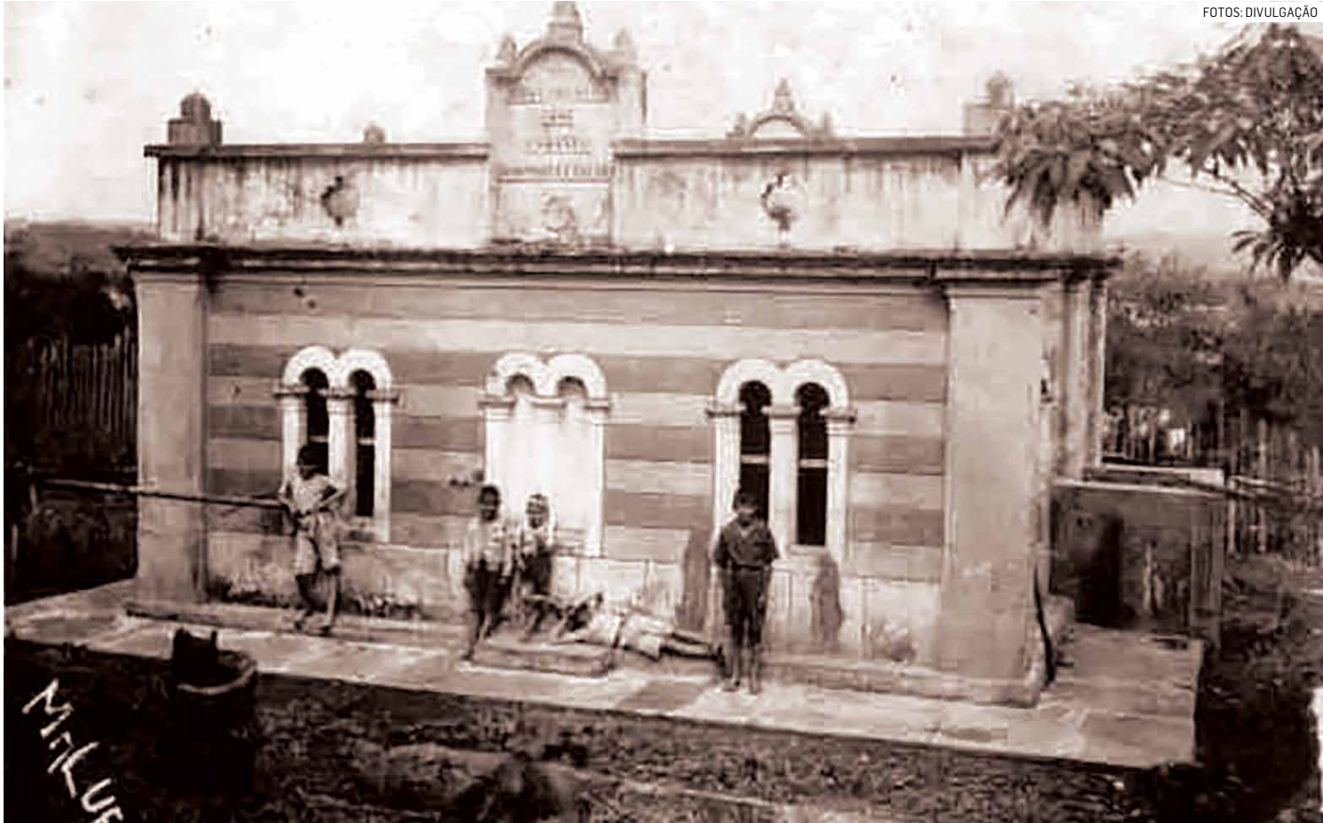
Reservatório de água
