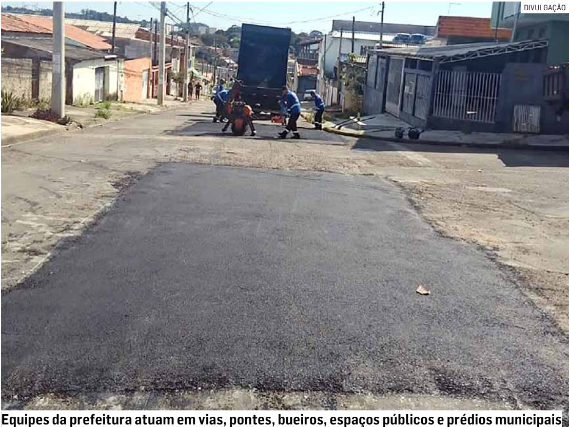
Equipes da prefeitura atuam em vias, pontes, bueiros, espaços públicos e prédios municipais
