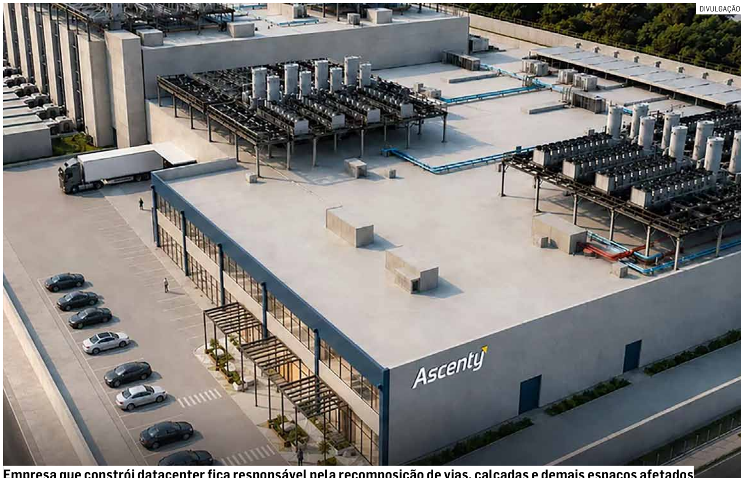
Empresa que constrói datacenter fica responsável pela recomposição de vias, calçadas e demais espaços afetados
