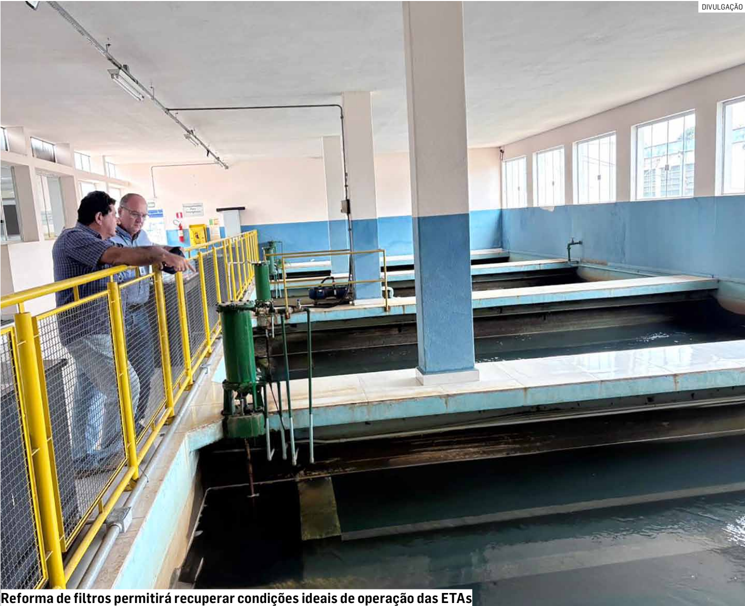
Reforma de filtros permitirá recuperar condições ideais de operação das ETAs
