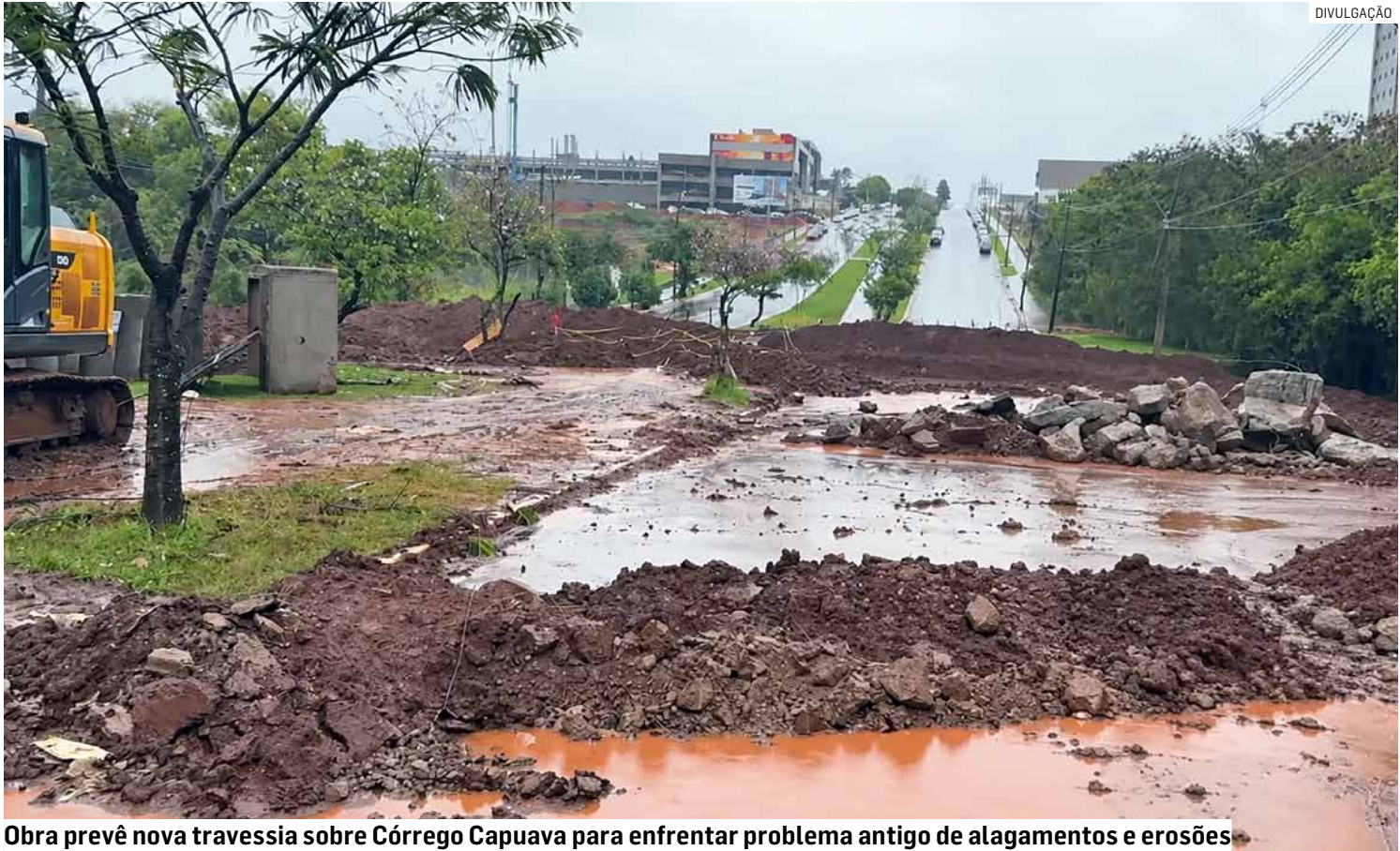
Obra prevê nova travessia sobre Córrego Capuava para enfrentar problema antigo de alagamentos e erosões
