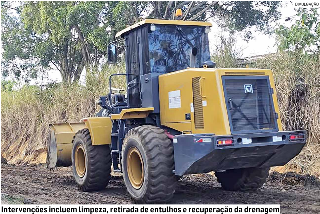
Intervenções incluem limpeza, retirada de entulhos e recuperação da drenagem
