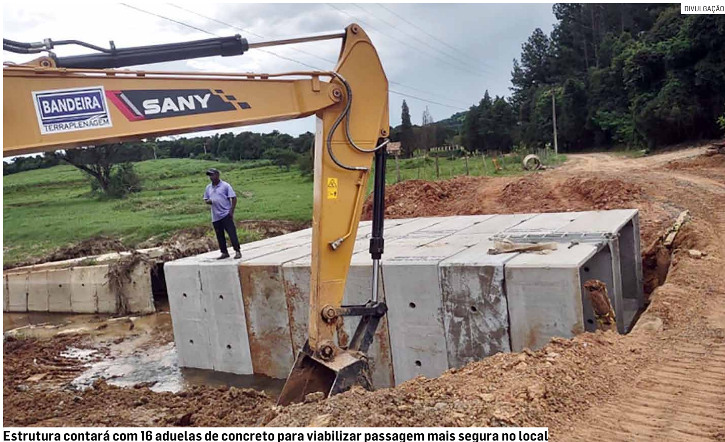
Estrutura contará com 16 aduelas de concreto para viabilizar passagem mais segura no local
