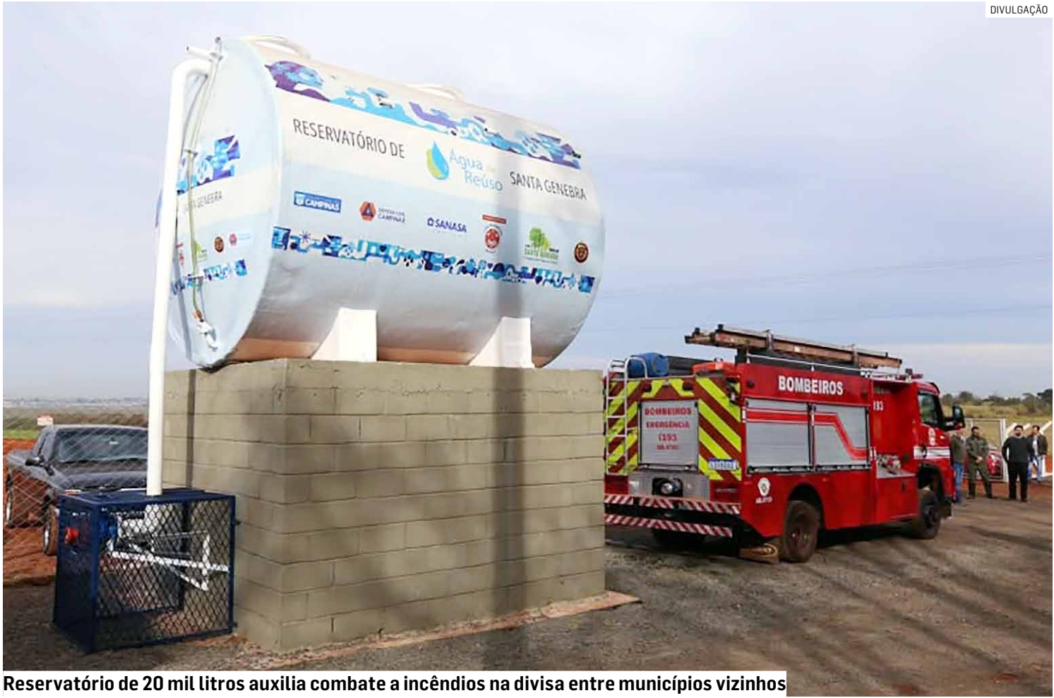
Reservatório de 20 mil litros auxilia combate a incêndios na divisa entre municípios vizinhos
