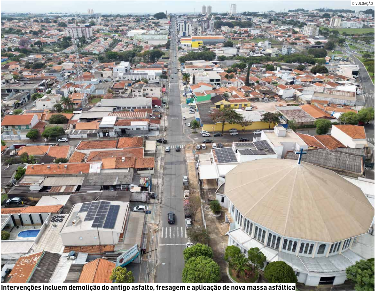
Intervenções incluem demolição do antigo asfalto, fresagem e aplicação de nova massa asfáltica
