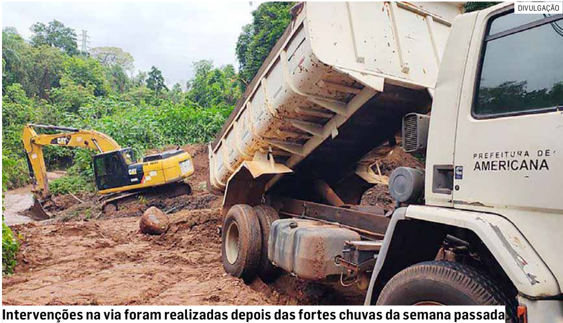
Intervenções na via foram realizadas depois das fortes chuvas da semana passada
