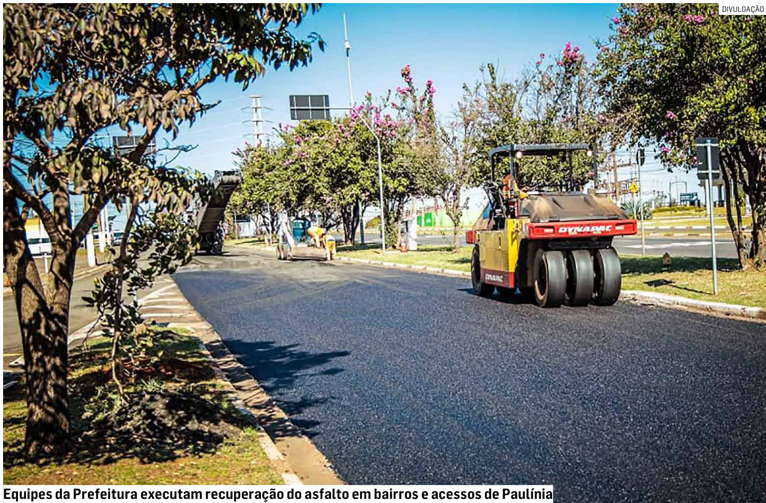
Equipes da Prefeitura executam recuperação do asfalto em bairros e acessos de Paulínia
