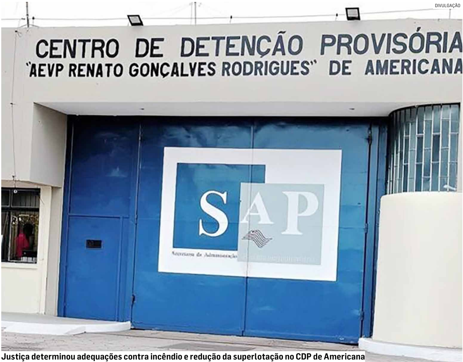
Justiça determinou adequações contra incêndio e redução da superlotação no CDP de Americana
