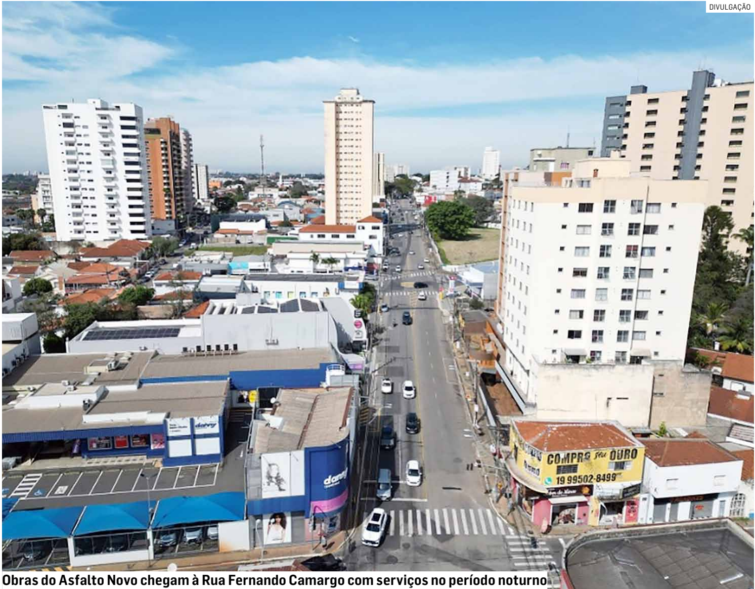
Obras do Asfalto Novo chegam à Rua Fernando Camargo com serviços no período noturno.
