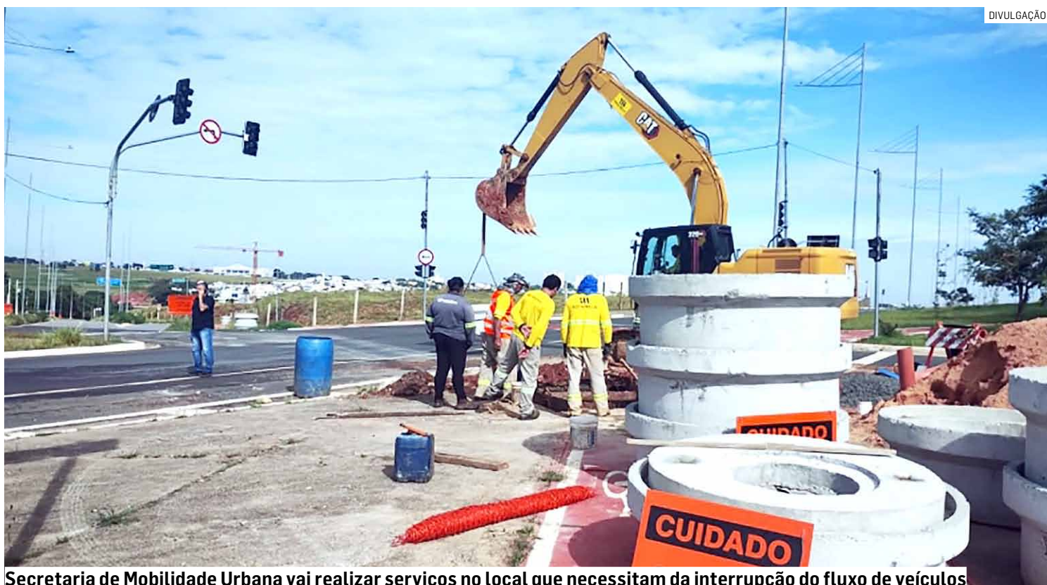
Secretaria de Mobilidade Urbana vai realizar serviços no local que necessitam da interrupção do fluxo de veículos
