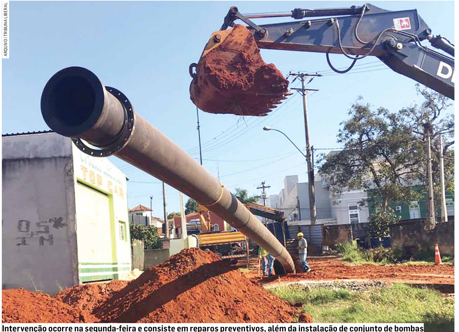
Intervenção ocorre na segunda-feira e consiste em reparos preventivos, além da instalação de conjunto de bombas
