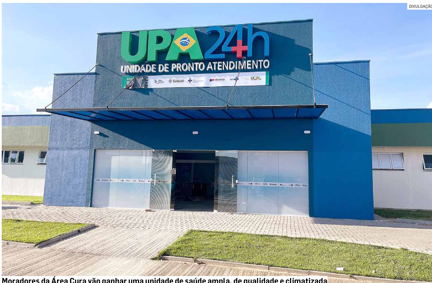
Moradores da Área Cura vão ganhar uma unidade de saúde ampla, de qualidade e climatizada
