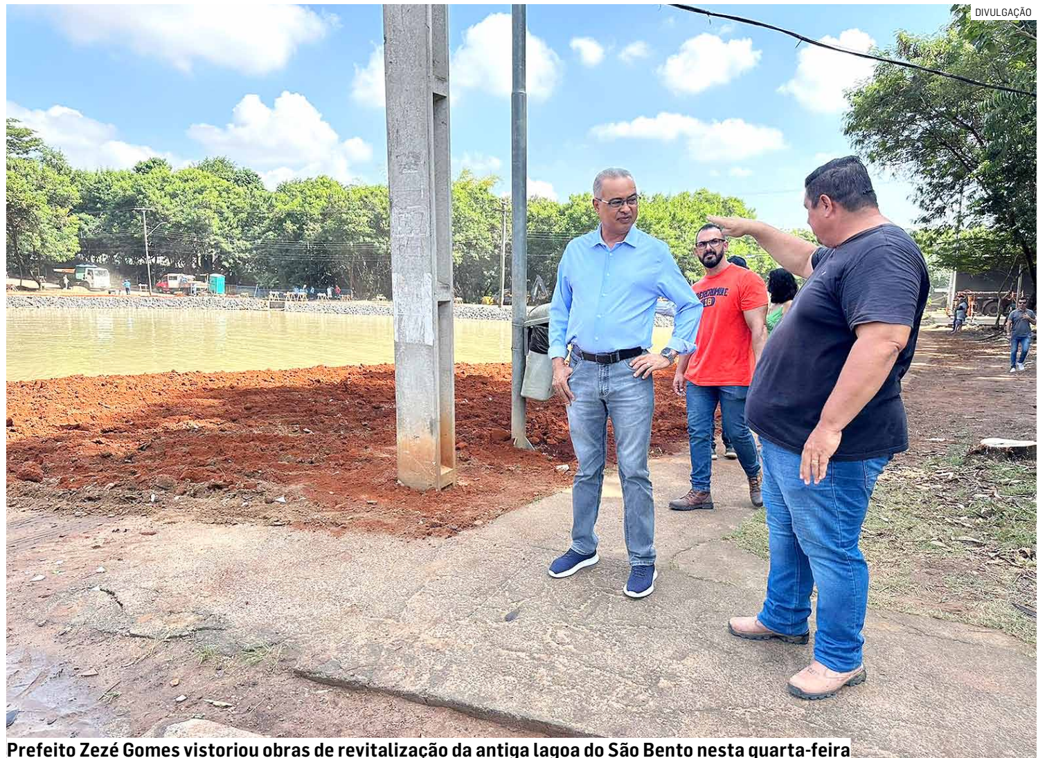
Prefeito Zezé Gomes vistoriou obras de revitalização da antiga lagoa do São Bento nesta quarta-feira
