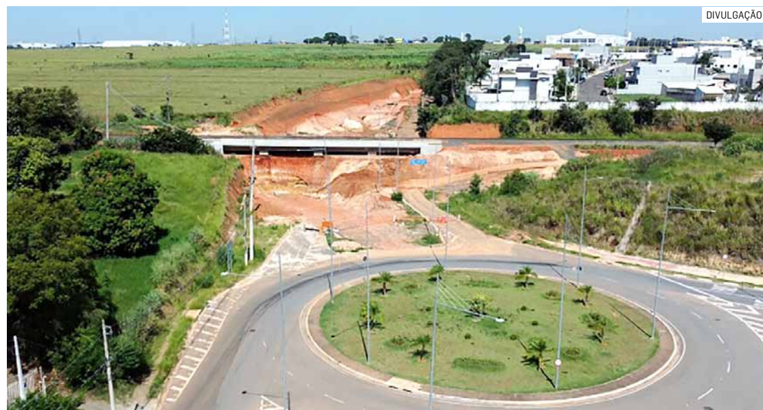
Intervenção foi necessária para executar duplicação da passagem inferior que existe no local
