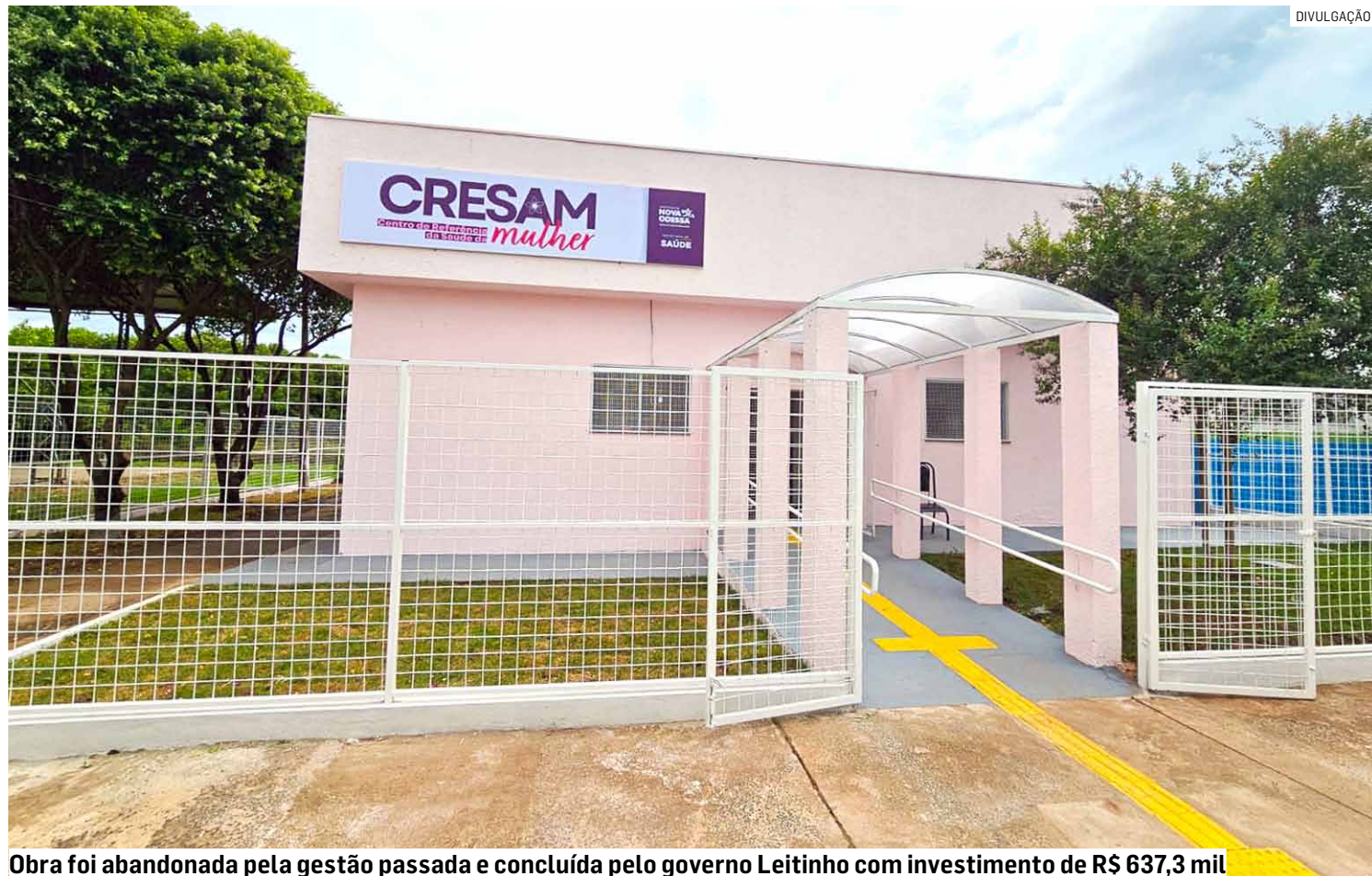
Obra foi abandonada pela gestão passada e concluída pelo governo Leitinho com investimento de R$ 637,3 mil
