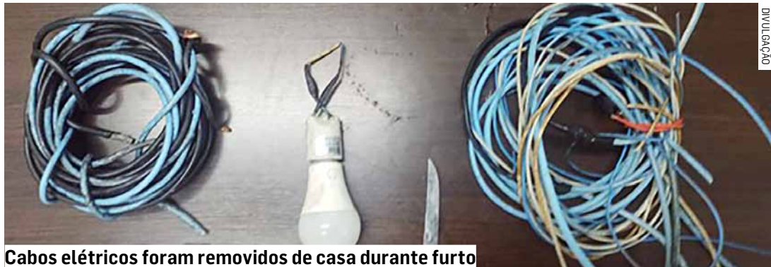
Cabos elétricos foram removidos de casa durante furto
