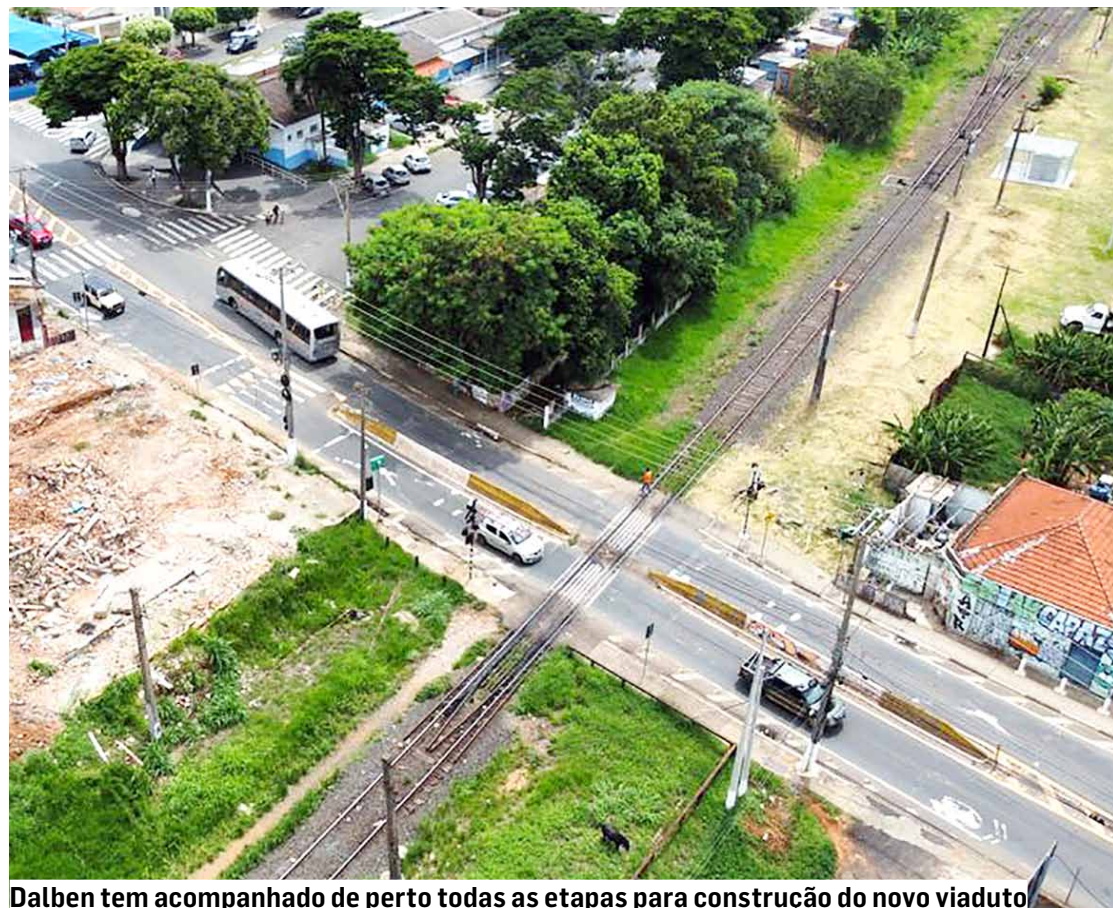
Dalben tem acompanhado de perto todas as etapas para construção do novo viaduto
